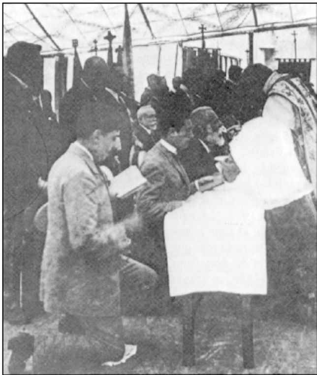
Гауди, получающий причастие во время Мессы во искупление богохульства, празднуемую под временным тентом, на месте которого теперь возвышаются нефы Святого Семейства.
